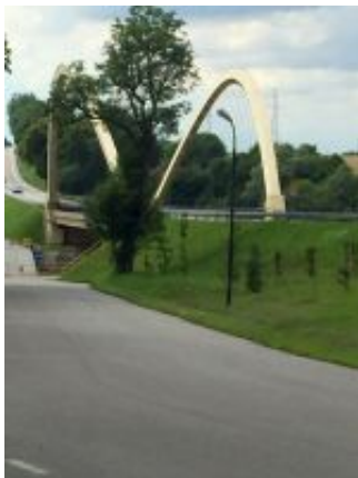
Die neue Lupowbrücke 2017
