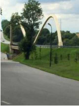
Die neue Lupowbrücke 2017
