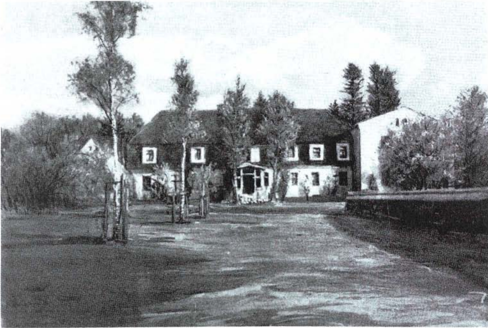
Gutshaus in Budow
