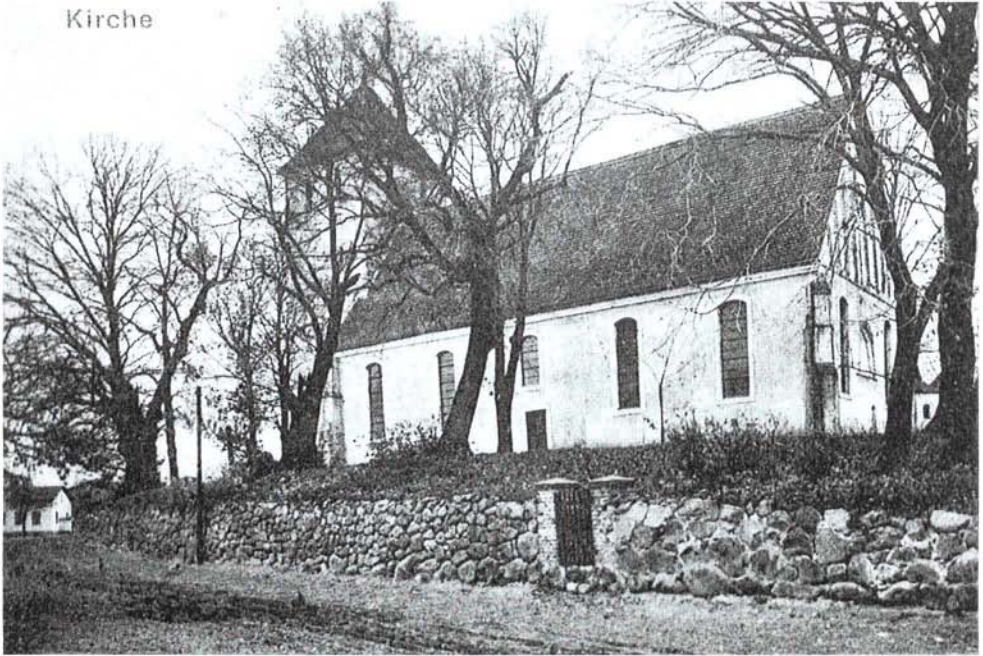
Die Kirche zu Budow
